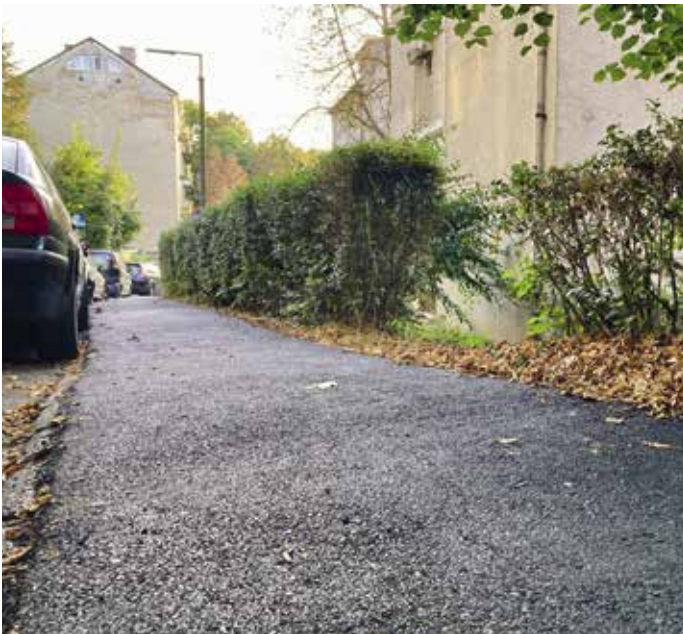
Folytatódtak a járdafelújítások a Szerpentin úton is, itt több szakaszt is érintett a beruházás.
