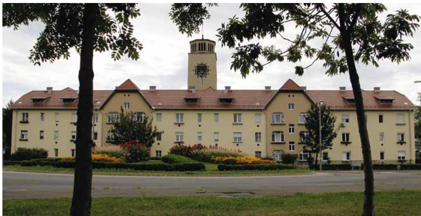
Felújított „kolduspalota”, 2000-es évek vége. A korszakban modernnek számító lakóépületeket az acélgyár építtette 1927-1928-ban.
